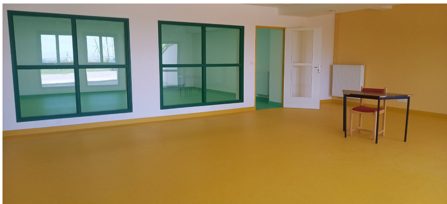
Nouvelles salles en rez-de-jardin
